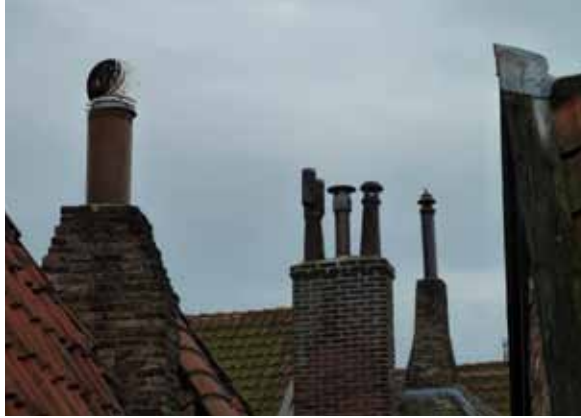
Luchtzuigers op ventilatiekanalen en schoorstenen
